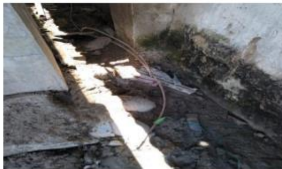
Gambar 2. 4 Titik pembumian setelah penanaman elektroda
