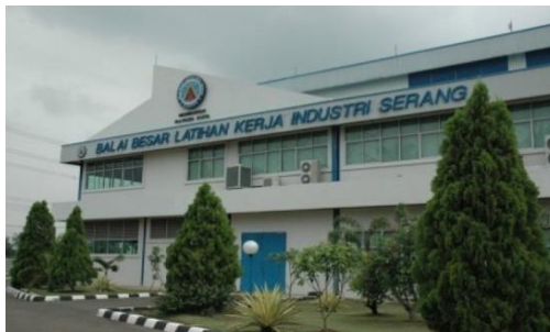
Gambar 3.4 Tampilan Bangunan BLKI Serang
