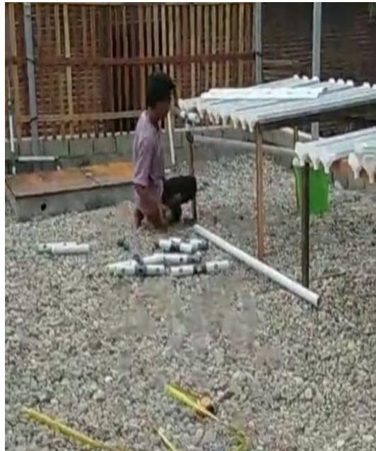
Gambar 6. Proses pembuatan instalasi hidroponik
