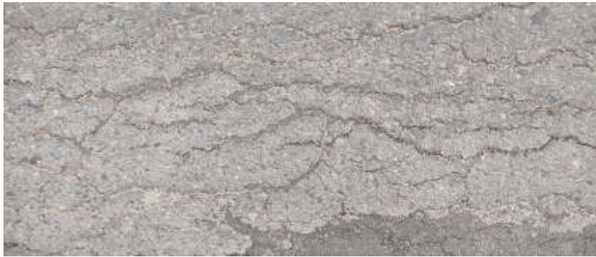
Gambar 2.2: Jalan Retak
