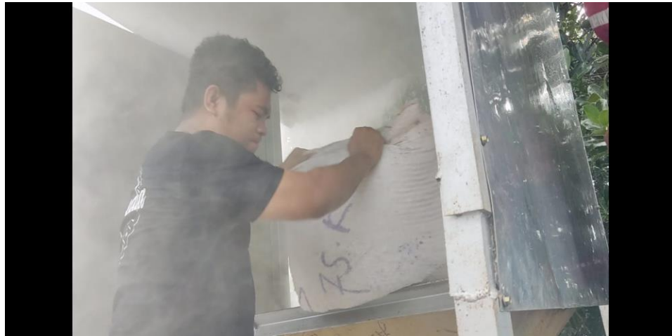
Gambar 4.4 Proses pemasukan bahan bakar ke reactor
