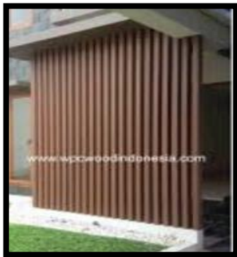
Kisi-kisi kayu Fungsi : Pembatas dan penghawaan alami serta estetika bangunan
