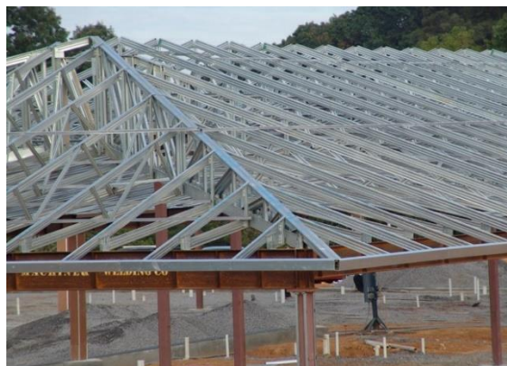
Gambar 5.35 Rangka Atap Baja Ringan
