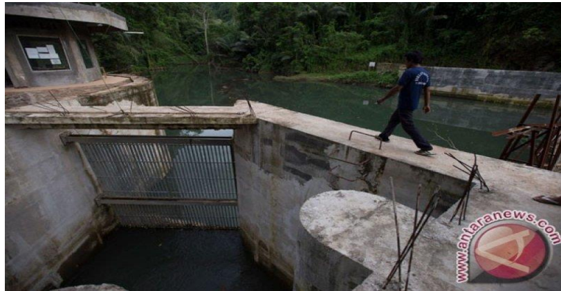
Gambar 2. 2 Saringan (Sand trap).
