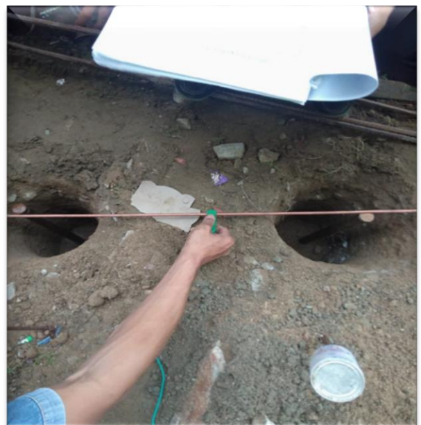
Gambar 21 (Pengukuran Batang Elektroda Pentanahan Yang Di Paralel)
