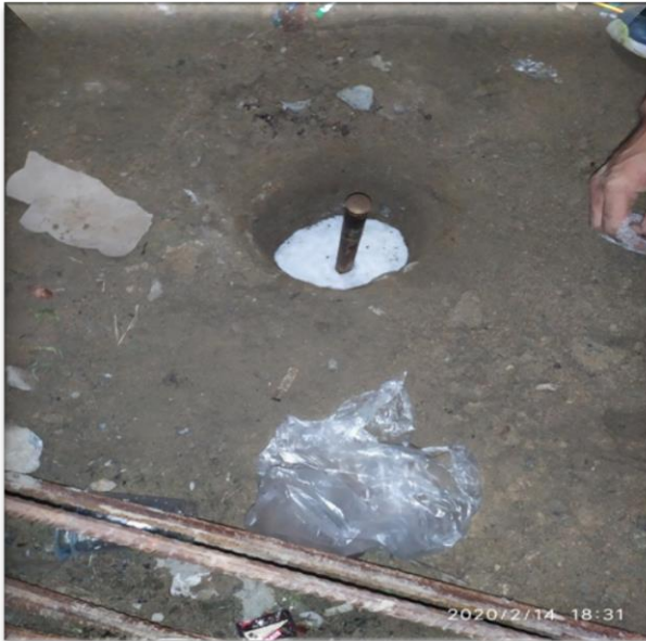
Gambar 20 (Pengukuran 1 Batang Elektroda Pentanahan)
