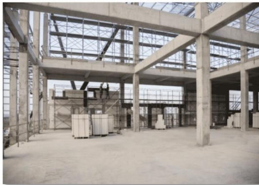
Gambar 5.15 : kolom dan balok Sumber : www. kumpulengineer. com,
