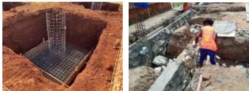
Gambar 5. 25 Pondasi FootPlat dan Pondasi Menerus Sumber : Analisa penulis, 2021
