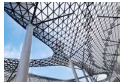
Gambar 5. 23 Struktur Plat Atap dan Space Frame
