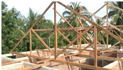
Gambar 5.46 : Struktur Atap Kayu
