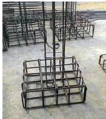
Gambar 5.47 : Pondasi Telapak Sumber : proyeksipil, 2022
