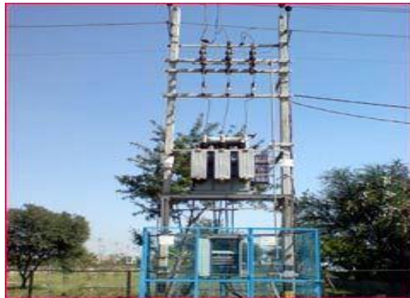
Gambar 2.2GTT Gardu Tiang Trafo
