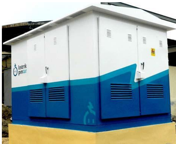
Gambar 2.6 Gardu Kios/ Gardu Metal Clad
