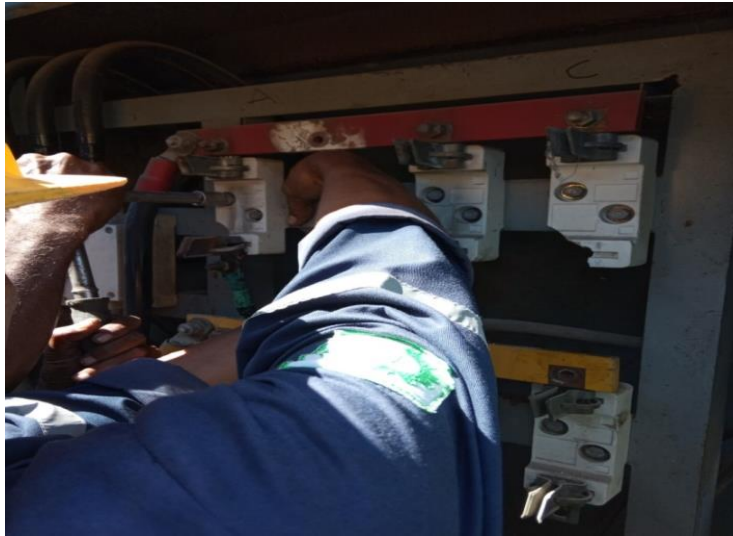
Gambar 2.12 Penggantian fuse base
