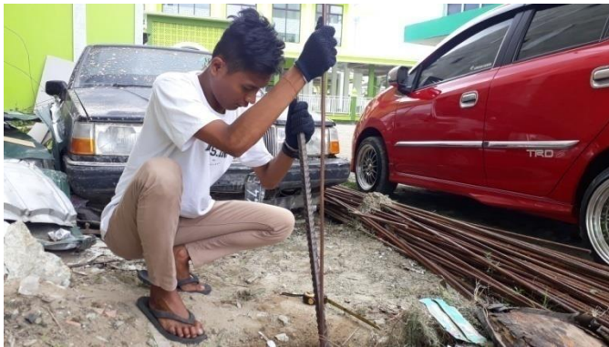
Proses Penacapan elektroda pada masing – masing kedalaman
