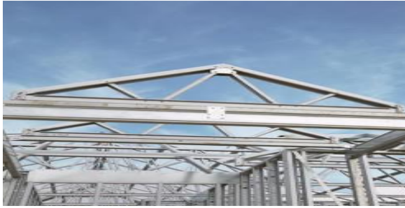
Gambar 15 Atap Rangka Baja/Baja ringan Sumber : Analisa Penulis, 2022
