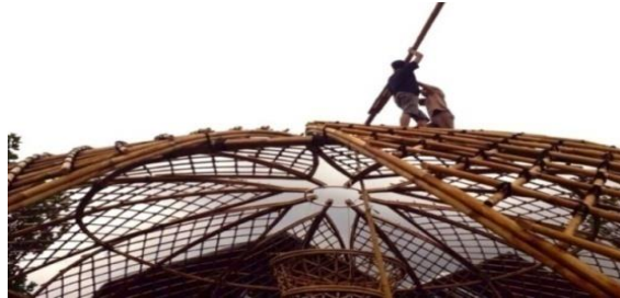
Gambar2.12 Konstruksi Atap Bambu Sumber: www.arsitag.com
