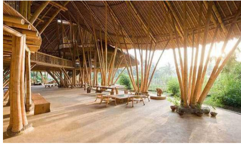
Gambar2.9 Tiang/Kolom Dari Bambu Sumber: www.arsitag.com
