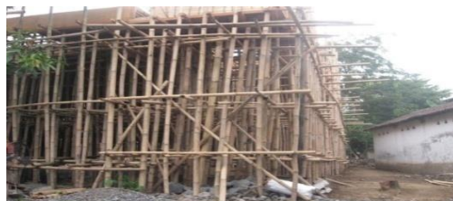
Gambar 2.8 Bekisting Sumber: www.arsitag.com
