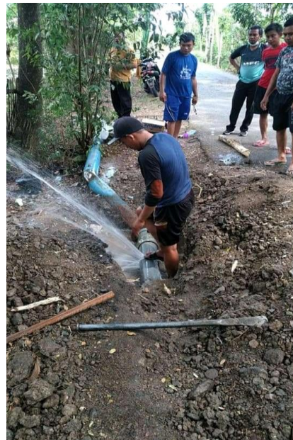
Gambar 3. Perbaikan Jaringan Pipa Distribusi
