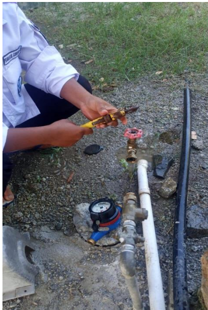
Gambar 4. Penggantian Meter Air Pelanggan
