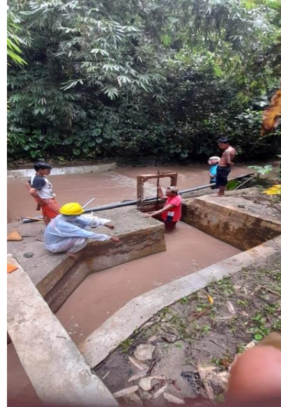
Gambar 1. Pengurusan Bak Pengambilan Air Baku
