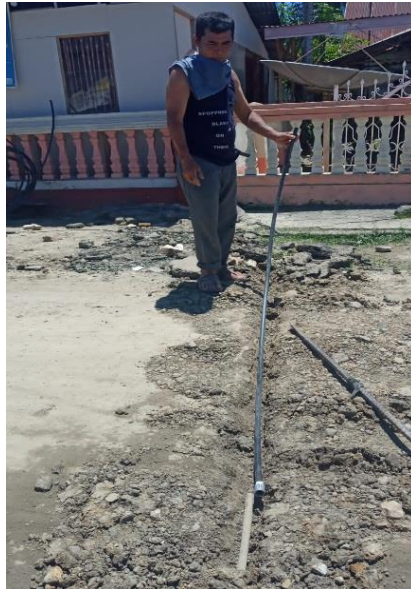
Gambar 2. Pemasangan Jaringan Distribusi
