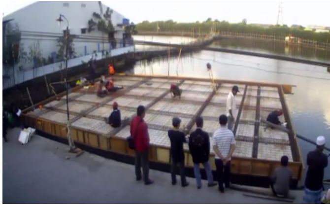
Gambar 2.4 Perakitan Tulangan Balok Dan Lantai Sumber : https://www.youtube.com/watch?v=K9JcB7ybsIc
