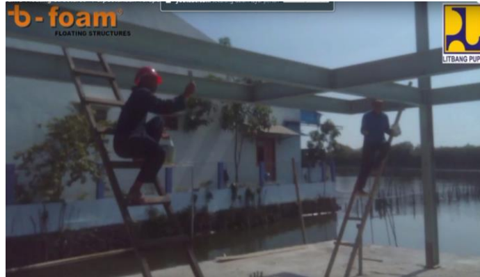
Gambar 2.6 Pemasangan tiang dan rangka atap Sumber : https://www.youtube.com/watch?v=K9JcB7ybsIc
